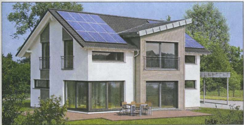
Foto: Fertighaus Weiss
