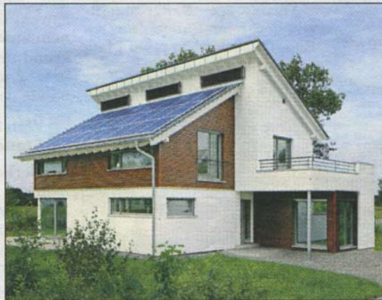
Ein Sonnenenergiehaus von Weiss.
